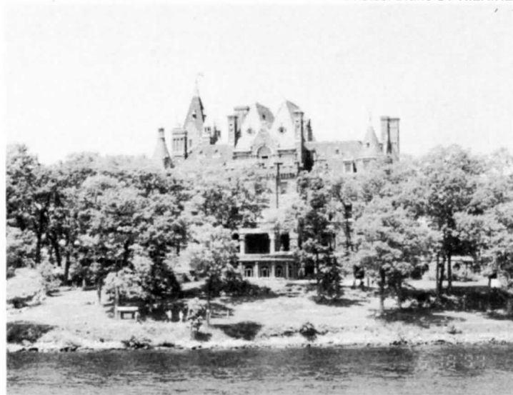
Réplique d'un château d'Allemagne sur une des Mille-Îles.
