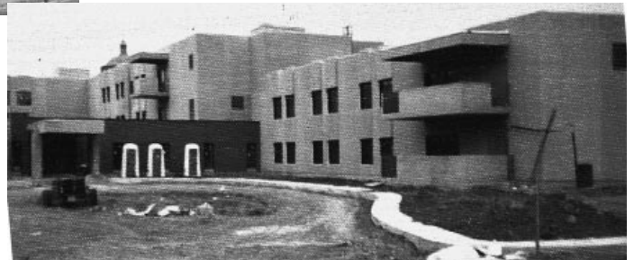
1978, le manoir en construction.
