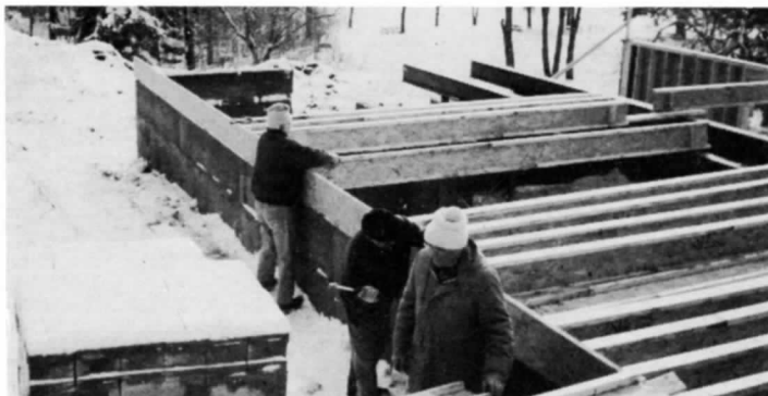
Samedi le 6 décembre, plusieurs bénévoles ont travaillé à la construction de l'auberge.
