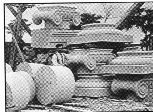
Quelques pierres des colonnes du portique qui serviront à la façade de l'Institution.
