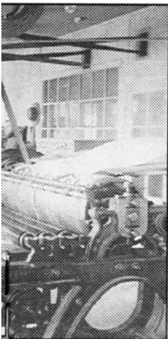
l'école d'imprimerie, à gauche, et celle de reliure, à droite. Électrifiées en 1889, les ateliers étaient alimentés par l'énergie électrique et on activait les machines à l'aide de moulinets fixés au plafond.
