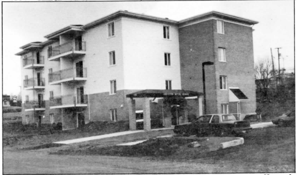
Un ensemble de 22 logements pour des familles et des personnes souffrant de surdité. Cet ensemble de logements est situé au 1545, rue Edith, à Charlesbourg.
